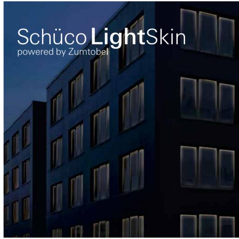
Система светодиодной подсветки Schüco позволяет подчеркнуть структуру и форму оконных элементов, особенно в ночное время. Благодаря сотрудничеству с компанией Zumtobel, ведущим международным поставщиком комплексных осветительных систем, Schüco удалось создать высокоэффективное решение, которое за счет своей фотометрии и уникального встраивания в профили идеально подходит для освещения оконных профилей Schüco.
